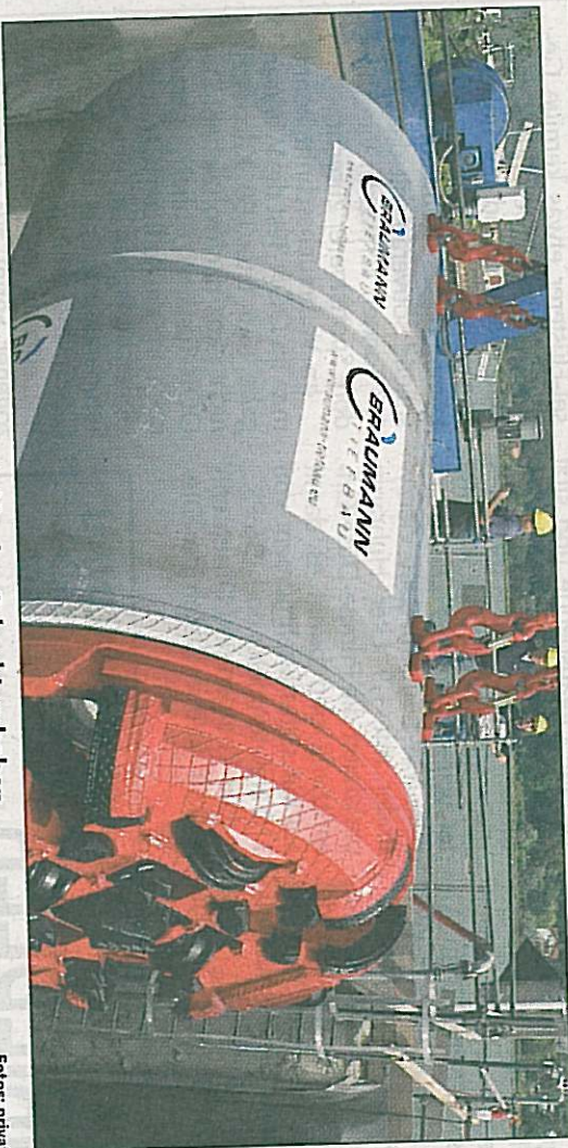
Die gewaltige Vortriebsmaschine wird in den Schacht gehoben.
