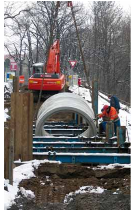
Sowohl die Modulgrößen als auch der Umstand, dass die Position der Laufwagen in bestimmten Bauphasen verändert werden kann, tragen zu einer reibungslosen Verlegung der Rohre bei.
