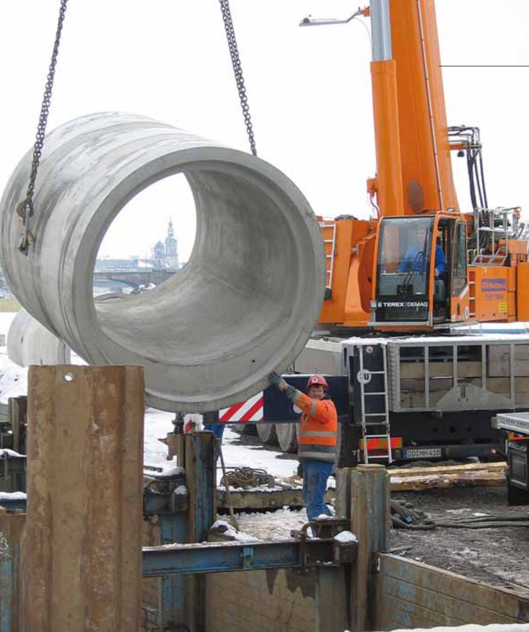
Just in time zur Einbaustelle: Ein Mobilkran hebt die 16 t schweren Stahlbetonrohre mit Dresdner Profil in die Baugrube. Fotos: Emunds+Staudinger GmbH
