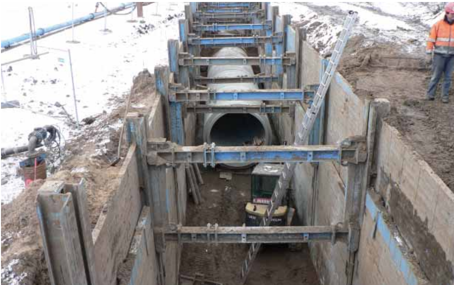
Vier bis zehn Module des Verbausystems – sie bestehen je nach Grabentiefe aus inneren und äußeren Grund- und Aufsatzplatten sowie Linearverbauträgern und den Laufwagen – werden bei dieser Baumaßnahme für Haltungslängen von bis zu 38 m eingesetzt.
