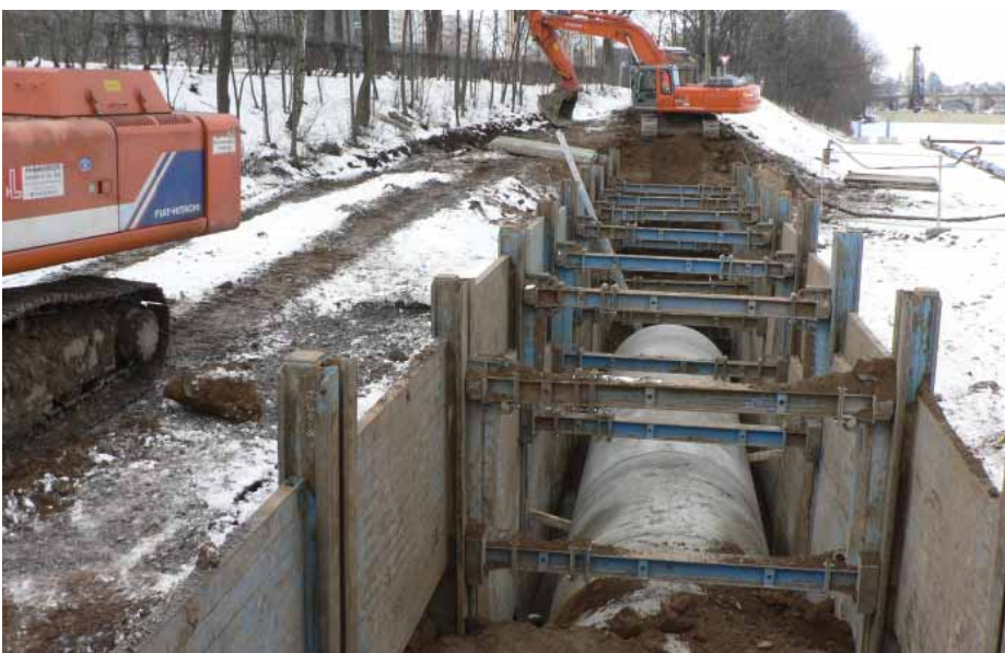
Mit dem Linearverbau Meter machen: Der reibungslose Ein- und Rückbau der Verbaumodule trägt zu einem schnellen Baufortschritt bei.
