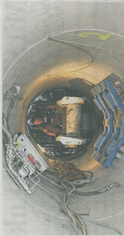
Hans Gruber befestigt gerade Leitungen.
