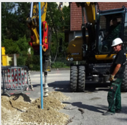
Bild 5: Vertikale Bohrlochsondierung
