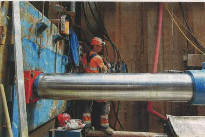
Mit hydraulischer Kraft treibt Thomas Schuster das Rohr in den Schacht.
