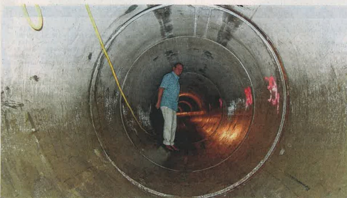
Im fertigen Teil des Stauraumkanals ist es kühl und hell. Wer nicht größer als 1,80 Meter ist, kann aufrecht durchgehen.
