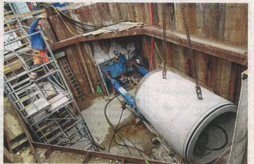
Der Kranfahrer wird beim Abladen eines Rohres eingewiesen.
