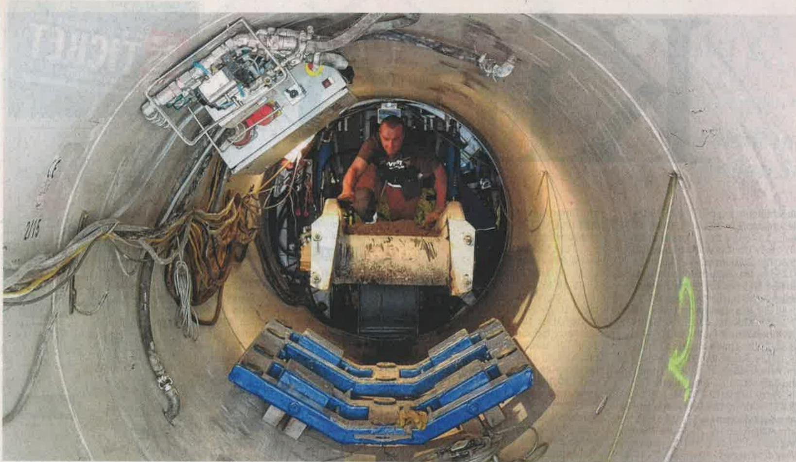
Hans Gruber klettert über das Förderband, auf dem sonst Erde in eine Lore befördert wird. Er ist gerade damit beschäftigt, Leitungen anzuschließen.
