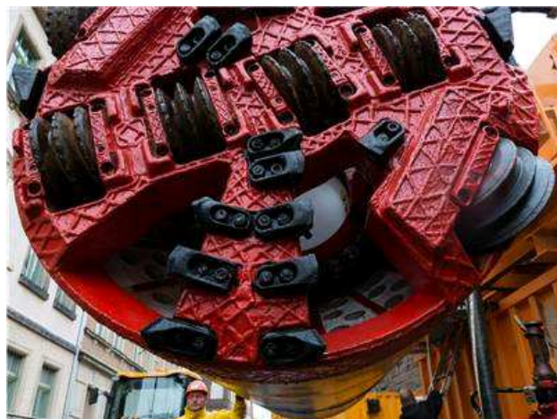
Vorarbeiter Ingo Böttcher von der Firma Baumann hilft, den Riesenbohrer in die Baugrube zu hieven. Der frisst sich nun durch den Untergrund der Altstadt.
